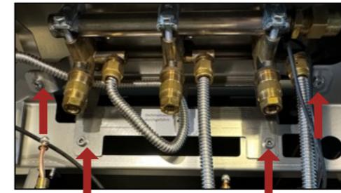
12. Befestigung der Gaseinheit lösen (TX25 oder 3mm Inbus)
